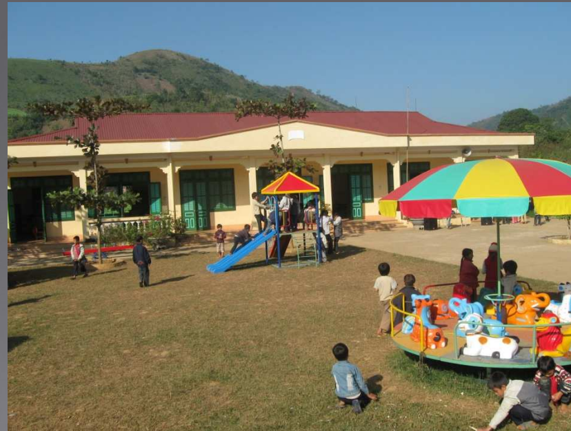
Schulgebäude mit Spielplatz
